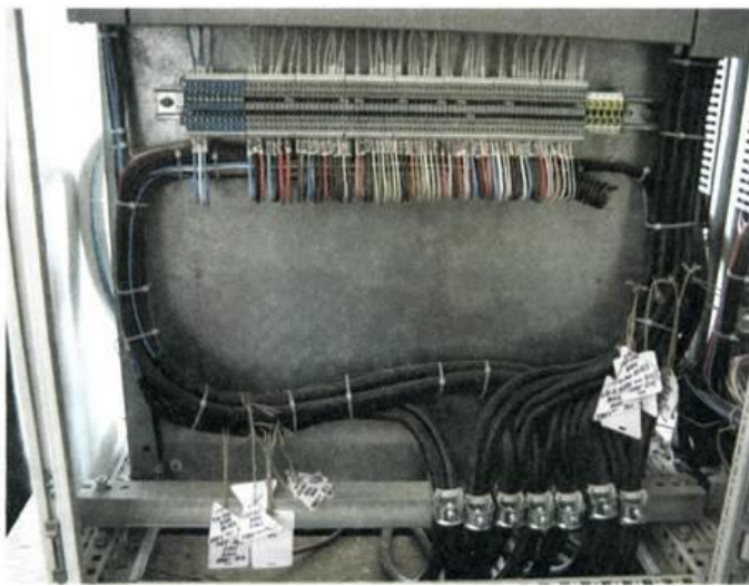
Рис. 8.1.1. Подвод контрольных кабелей снизу электроконструкции.
