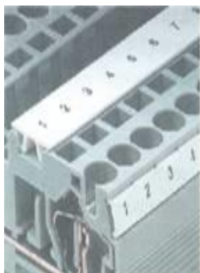
Рис. 7.3.2. Маркировка наборных зажимов
